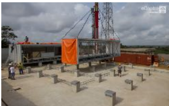
Ett eCentre, Flexenclosures världsledande produkt inom den snabbväxande marknaden för prefabricerade modulära datacenter, sänks på plats i Elfenbenskusten för kunden MTN
