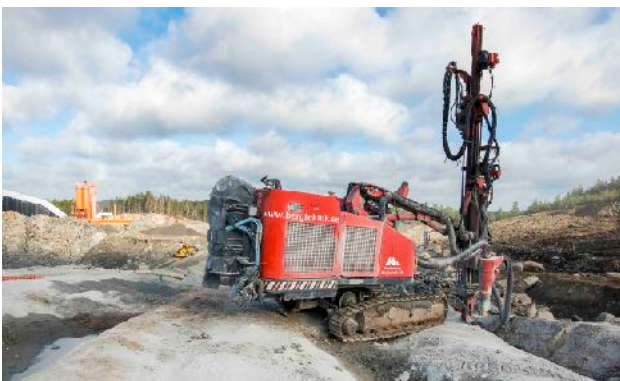
En borrhög från Norrbottens Bergteknik, ett av Nordisk Bergtekniks dotterbolag. Nordisk Bergteknik är exempel på ett navbolag i Basportföljen, runt vilken Pegroco gör tilläggsförvärv.
